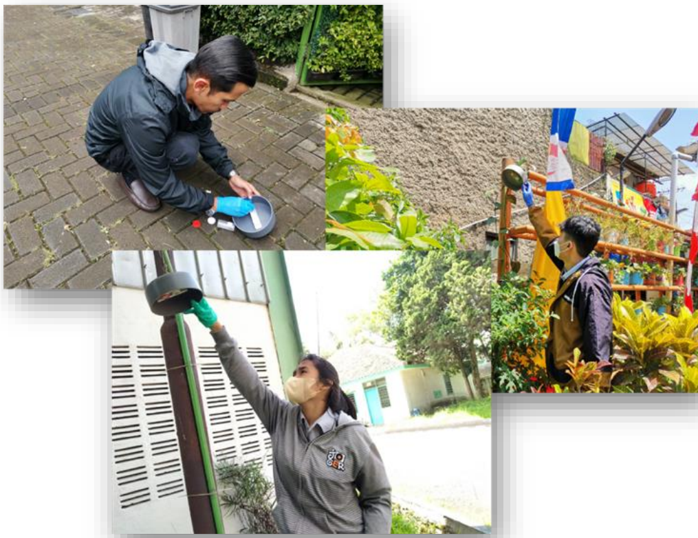
Kegiatan Pemasangan Alat Pemantauan Kualitas Udara Ambien di Permukiman dan Perkantoran
