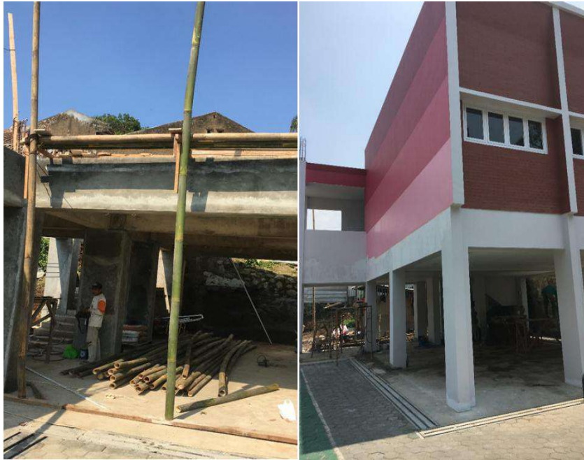
Pembangunan ruang laboratorium komputer beserta perabotnya - SMP IT Nur AL Rahman
