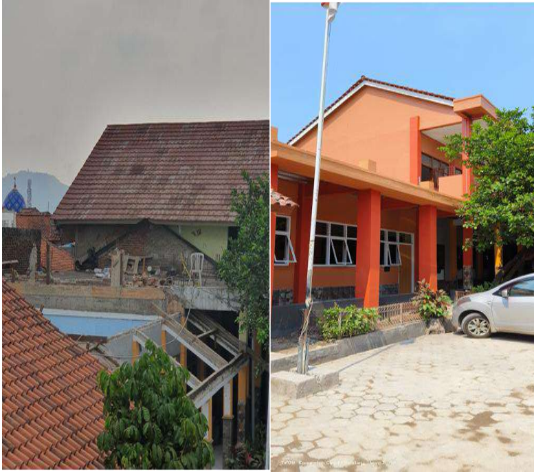
Pembangunan Laboratorium Sekolah Dasar Negeri Melong Mandiri 5 Cimahi
